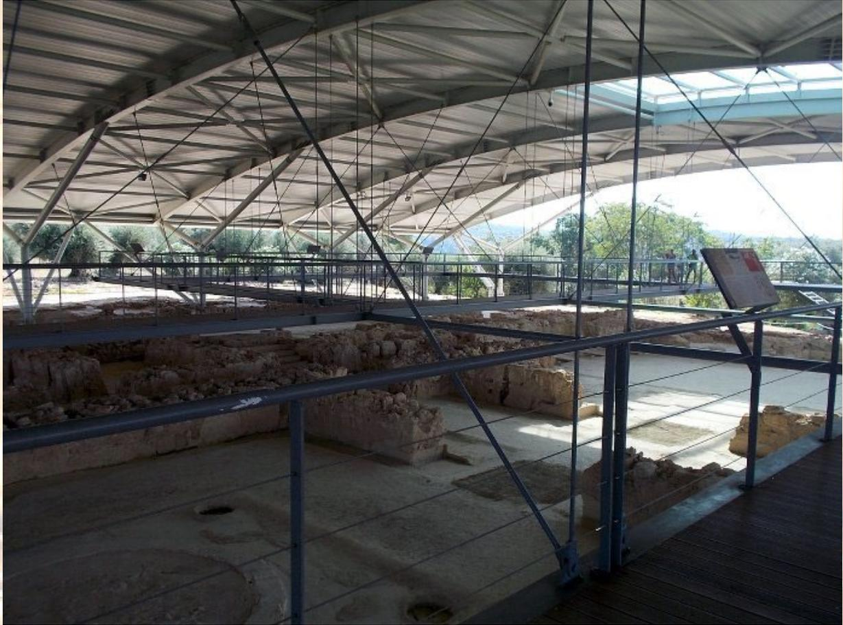
Figura 43 Pilo Palazzo di Nestore, la moderna tensostruttura.
